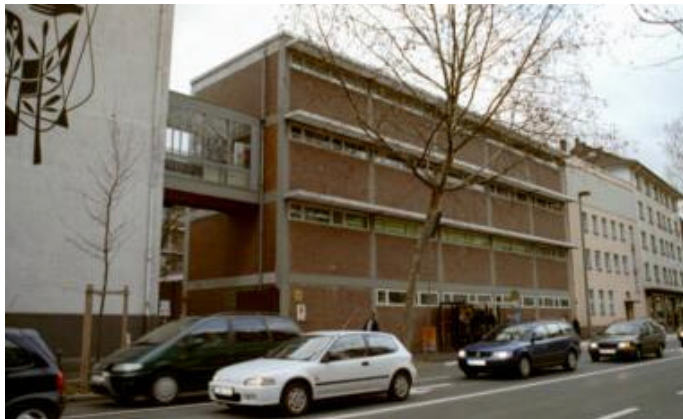
Holzstraße und Rheinstraße der Fachhochschule Mainz wurde das moderne Gigabit-Ethernet-Netzwerk installiert. (Quelle: improve)
