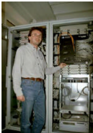
Stefan Pauly, der maßgeblich am Aufbau des Netzes beteiligt war, plant und betreut die Netz- und DV-Installationen der FH-Mainz zusammen mit seinem Kollegen Hartmut Weiner. (Quelle: improve)
